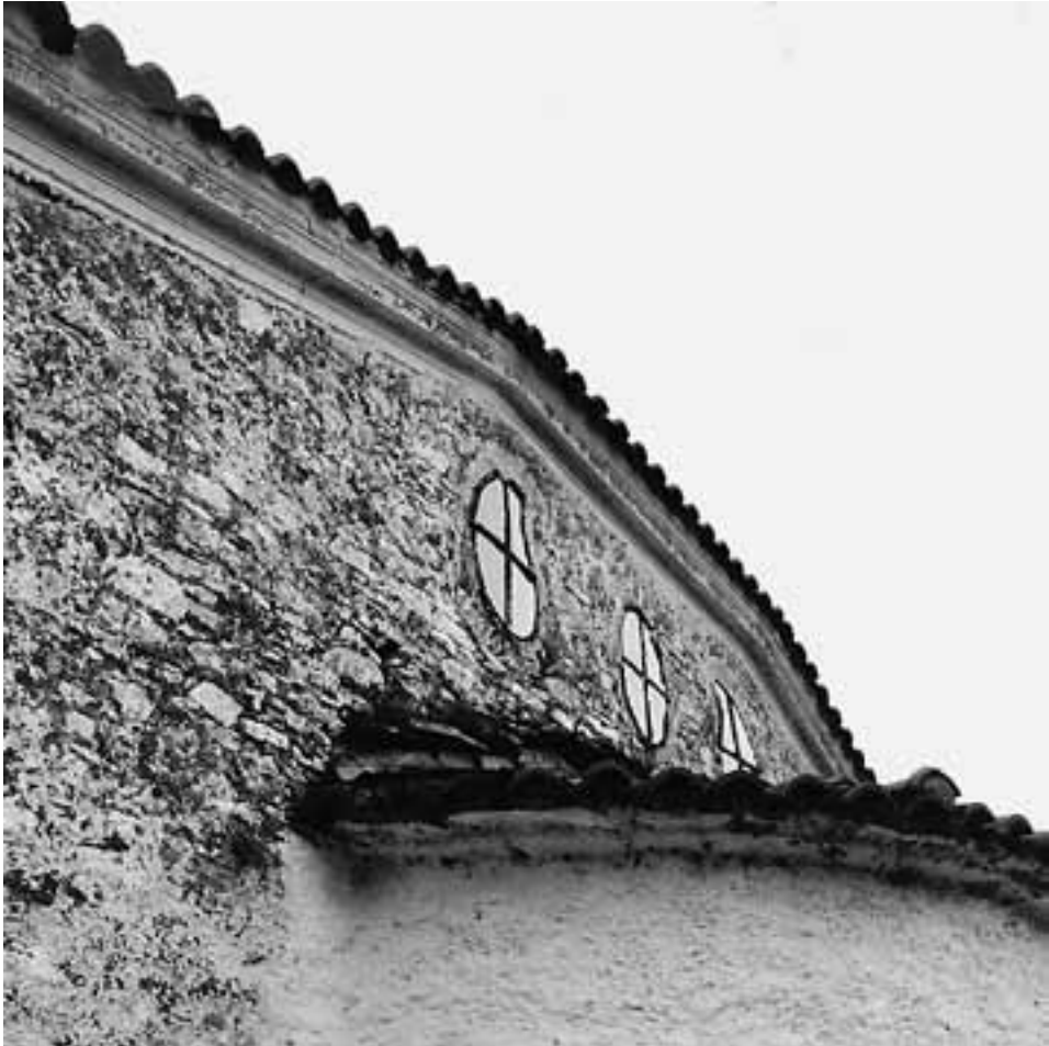
Εικ. 90Γ. Οικισμός Τέμπη. Αγία Τριάδα 1896. Οι αχλαδόσχημοι φεγγίτες με διαφορετικό φωτισμό και υπό διαφορετική γωνία λήψης εικόνας. Ιδιαίτερα διδακτική η τελευταία συνθήκη για τον τρόπο φωτογράφισης των αχλαδόσχημων φεγγιτών. Βλ. το χτυπητό παράδειγμα εικ. 84Β & 86Γ (Άγγελος Σινάνης: DSC 9254 της 01.04.2011).
