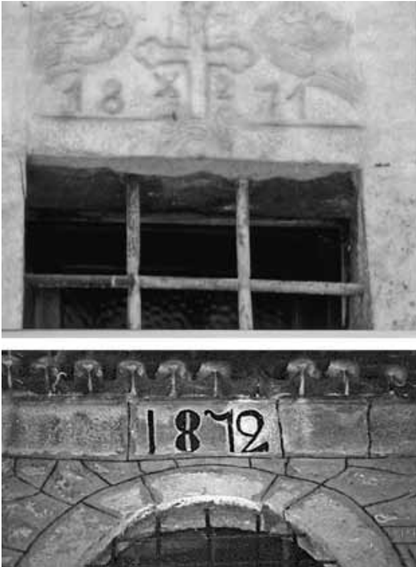
Εικ. 53Ba & Bβ. Τύρναβος. Φανερωμένη. Επιγραφές χρονολογιών. – Ba (επάνω): Ανατολική όψη «1871» στο υπέρθυρο φωτιστικής θυρίδας αψίδας ιερού. – Bβ (κάτω): Δυτική όψη «1872» στο γείσο στέγης (Α.Π. Βα SANYO 133, 05.03.2011, Ββ 05.12.1992).
