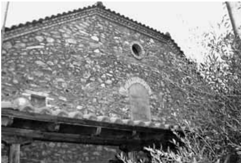
Εικ. 105. Ομόλιον. Άγιος Κωνσταντίνος. Δυτική στενή πλευρά: διακρίνεται η διαφοροποίηση του υψηλότερου νέου χτισίματος για την υπερύψωση της στέγης από το παλαιότερο κάπως πιο σκούρο (Α.Π. SANYO 060 της 20.02.2011).
