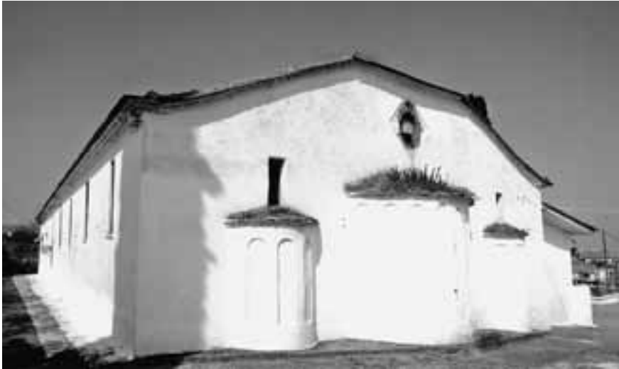
Εικ. 33Α. Άγιος Γεώργιος Φερών. Βασιλική Αγίου Γεωργίου. Νοτιοανατολική όψη, η περισσότερο ανέπαφη πλευρά από μεταγενέστερες επεμβάσεις (Άγγελος Σινάνης, DSC 9938 της Κυριακής 03.04.2011).
