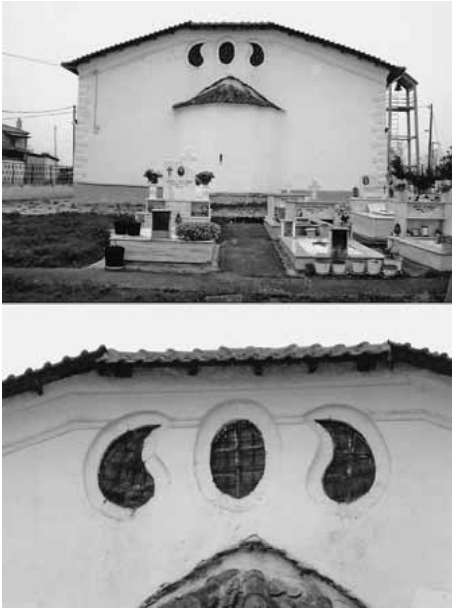
Εικ. 72Α (πάνω) & 72Β. Γυθιώνη, Άγιος Αθανάσιος [πριν το 1873]. Ανατολική όψη. -Α: συνολική άποψη. -Β: λεπτομέρεια αχλαδόσχημων φεγγιτών (Α.Π. SANYO αντίστοιχα 110 & 111, 05.03.2011).
