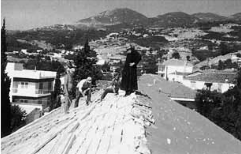
Εικ. 46Γ. Πυργετός. Άγ. Γεώργιος. Από εργασία επισκευής στέγης υπό εποπτεία π΄ Αλεξάνδρου (: Αλεξ. Ρούσσας, 2007, σ. 25).
