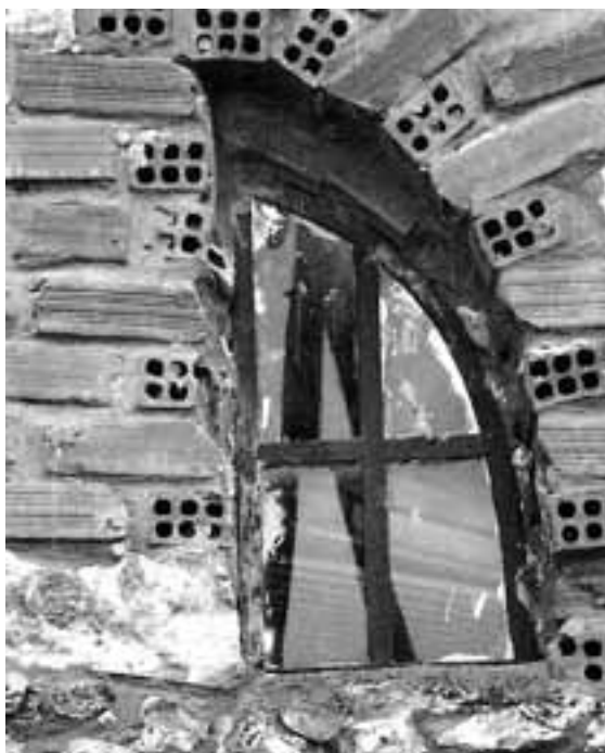
Εικ. 98. Βοτανοχώρι. Άγιος Νικόλαος. Η δυναμική μορφή ενός φεγγίτη από διάτρητα τούβλα (Α.Π. SANYO 140 της 05.03.2011).
