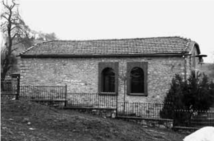
Εικ. 95. Βοτανοχώρι Τυρνάβου. Εκκλησία Αγίου Νικολάου. Βόρεια όψη (Α.Π. SANYO 146 της 05.03.2011).
