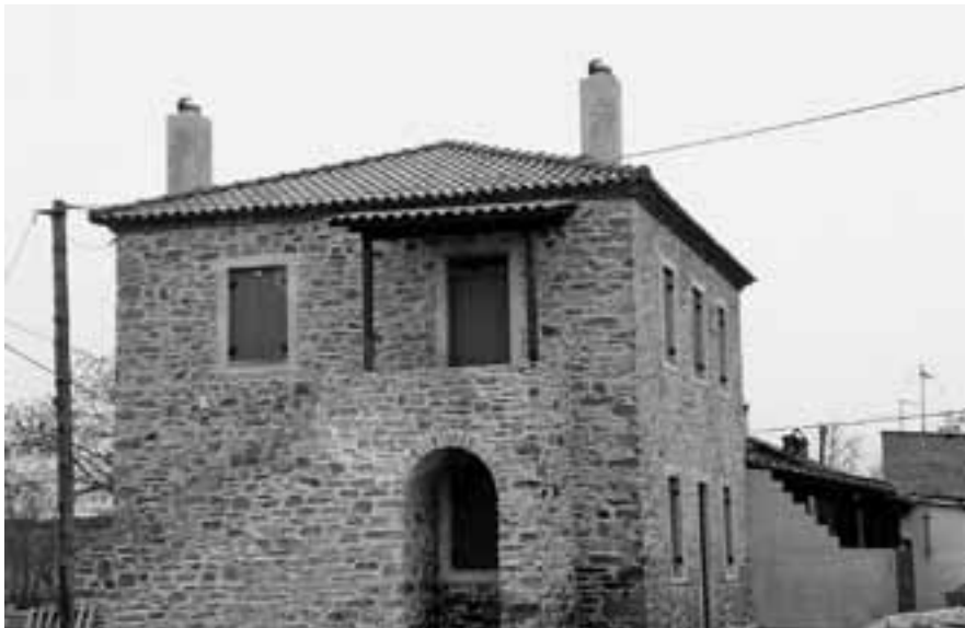
Εικ. 74. Γυρτώνη. Αξιόλογη εύτεχνα πετροχτισμένη οικία με εξωτερικό κλιμακοστάσιο, δίπλα (νότια) στο ναό Αγίου Αθανασίου (Α.Π. 05.03.2011).
