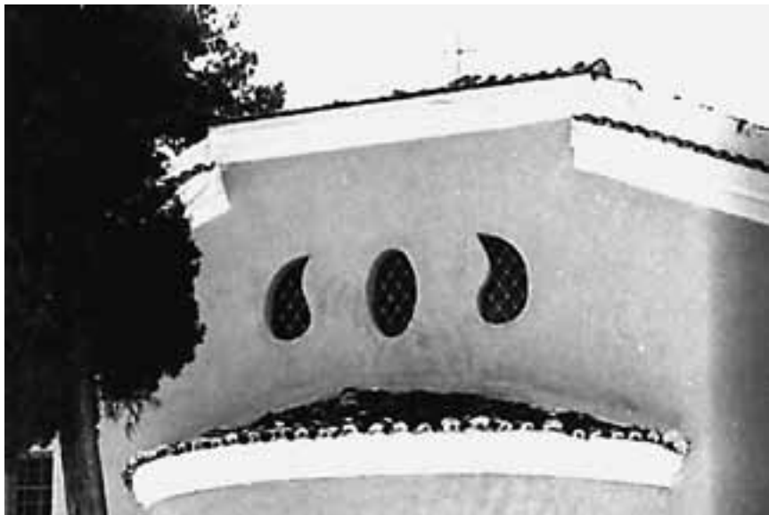
Εικ. 51Β. Τύρναβος. Αγία Παρασκευή. Ανατολική όψη. Λεπτομέρεια με φεγγίτες (Α.Π. 1992;).
