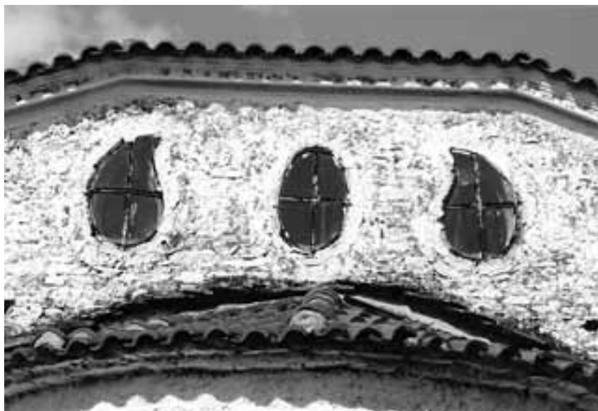
Ειχ. 90Β. Οικισμός Τέμπη. Αγία Τριάδα 1896. Οι αχλαδόσχημοι φεγγίτες στην ανατολική όψη (Α.Π.: Φ. 05.V/4-VI/1 αρ. 13 της 24.06.2005).
