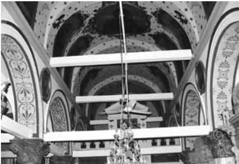
Εικ. 40. Άγιος Γεώργιος Αγίου Γεωργίου Φερών. Εσωτερικό. Μεσαίο κλίτος καμαροσκεπές με σφενδόνια. (Α.Π. 20.02.2011).
