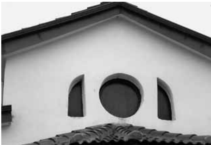
Εικ. 101Α. Ολυμπιάδα. Άγιος Γεώργιος. Οι «αχλαδόσχημοι φεγγίτες» στην ανατολική όψη (Α.Π. SANYO 157 της 05.03.2011).
