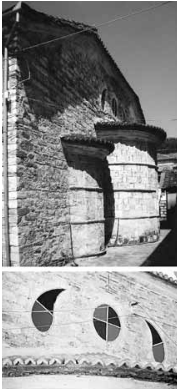
Εικ. 29Α & Β. Αγιά. Άγιος Αντώνιος, Ανατολική όψη: (Α) σύνολο & (Β) λεπτομέρεια. 1856-1857. Αχλαδόσχημοι φεγγίτες ανατολικής όψης υπέρ την κόγχη του ιερού βήματος. (Α.Π. - Α: SANYO 335 της 03.04.2011. - Β: της 05.12.1992).
